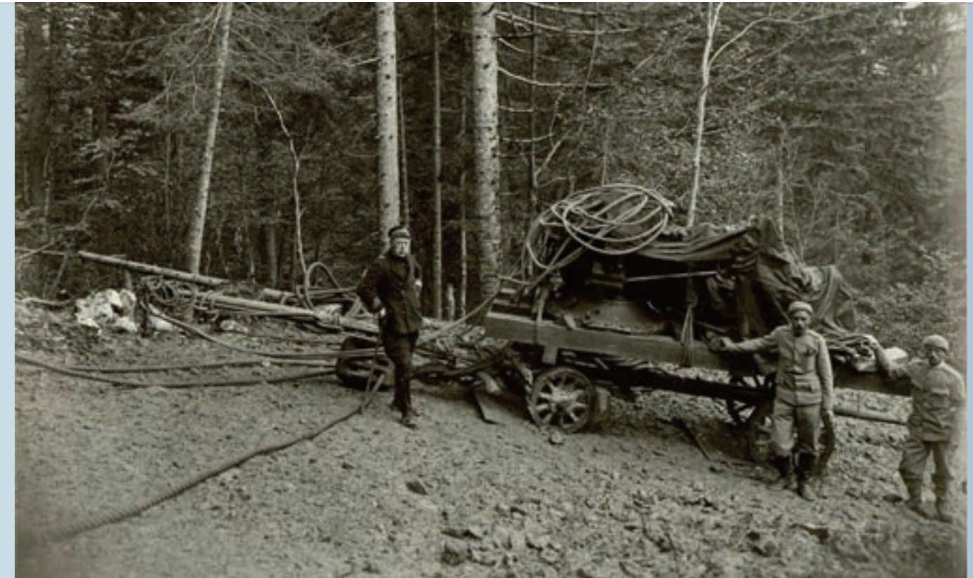
Dostava strojev in drugega materiala na traso žičnice je običajno potekala po prej pripravljenih zasilnih poteh, ki so se kasneje uporabljale za vzdrževanje in kontrolo žičnice. (foto: Europeana)
