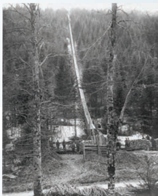
Lesena drča za premostitev višinske razlike do ozkotirne poljske železnice, ki je drva odvažala do žičnice. (foto: Europeana)
