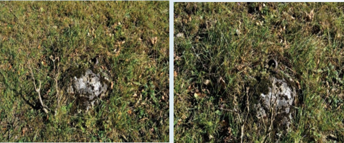
Betonska bloka s kovinskim obročem za utrditev stebra. (foto: Boris Blažko)
