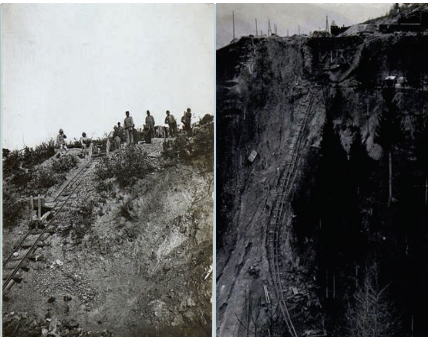
Primer vojaške vzpenjače za prevoz tovora. Delovala je na principu železniških tirov in povezave ter vleke z jeklenico. (foto: Europeana )
