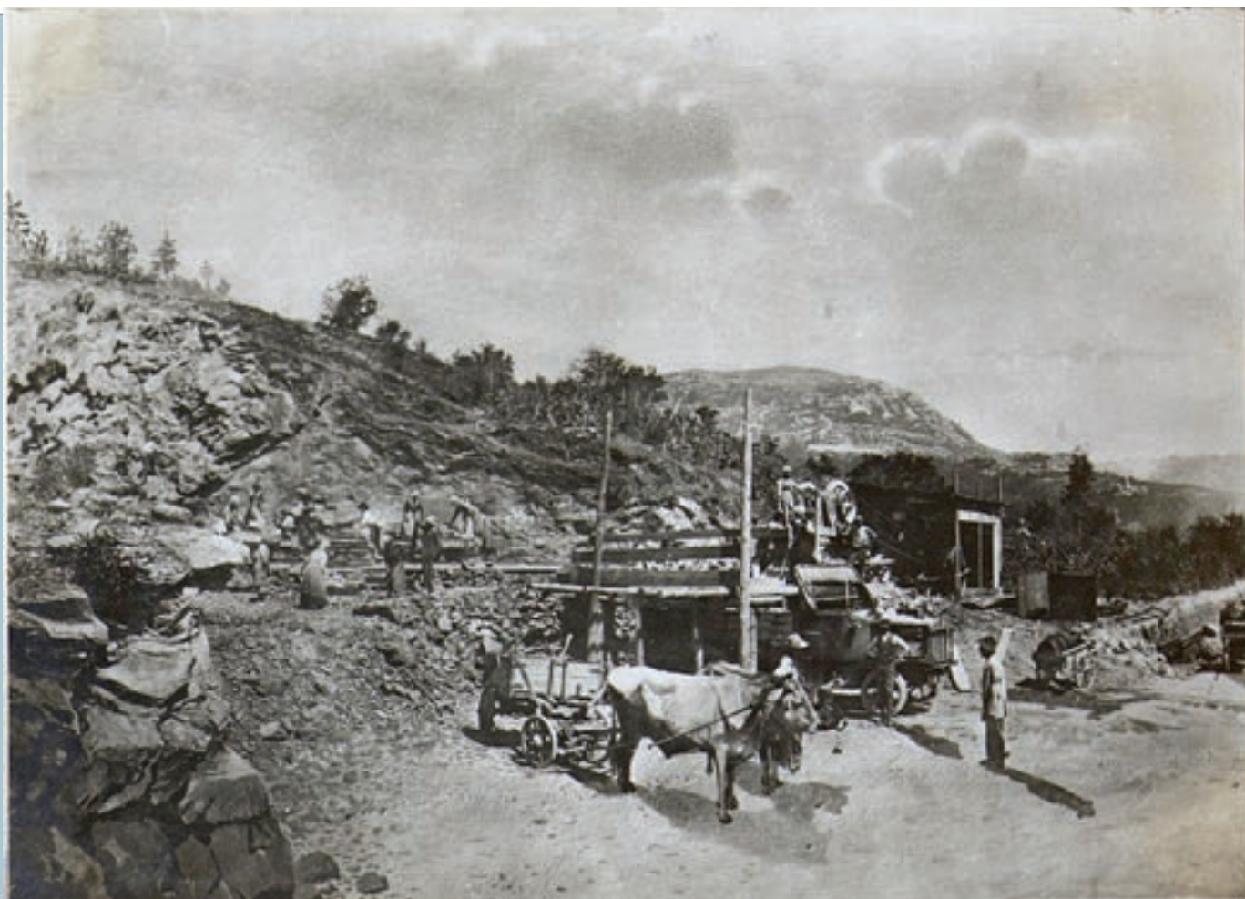
Kamnolom v Dobravljah in natovarjanje kamenja na voz ter kamion za utrjevanje cest. (foto: Europeana))
