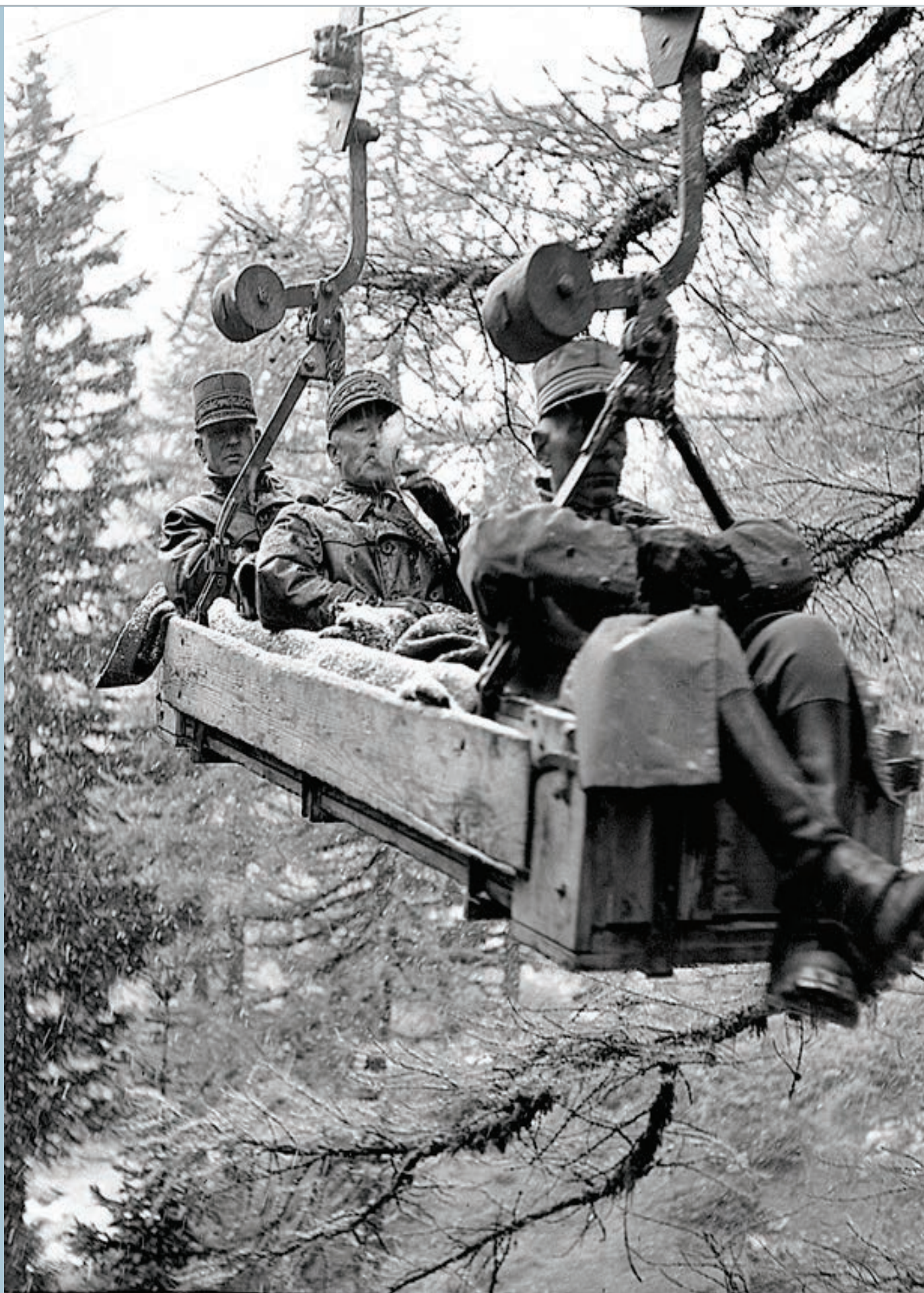
Obachov sistem vklapljanja vozičkov na žičnici na italijanski strani. (foto: Europeana)
