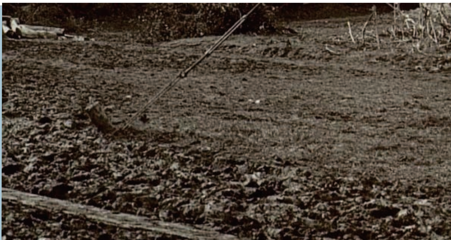
Izsek fotografije, kjer je napenjalna stebrna jeklenica z napenjalcem vpeta na lesenem količku, ki je zabit v tla pod kotom. (foto: Goriški muzej)
