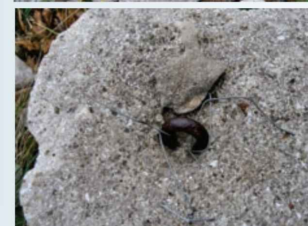
Betonski blok, katerega je lastnik parcele v Lokavcu ob sajenju nasada oljk izkopal in ga ima ob meji parcele kot okras in stol za sedenje. Vsak steber je imel 4 take zabetonirane kovinske zapenjalce. (foto: Boris Blažko)
