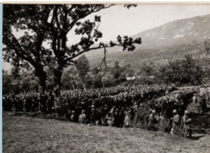
Italijanski vojni ujetniki po končani ofenzivi, postrojeni na območju pod Črničami. (fototeka: Goriški muzej)
