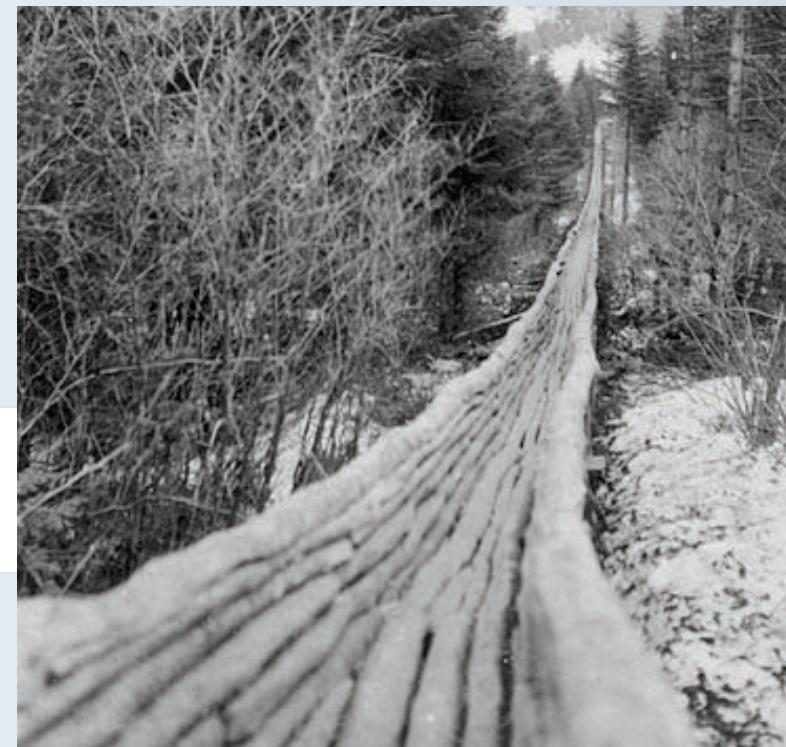
Lesena drča za premostitev višinske razlike do ozkotirne poljske železnice, ki je drva odvažala do žičnice. (foto: Europeana)
