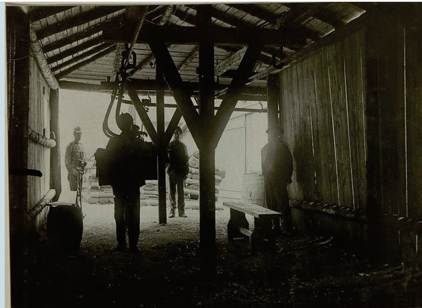
Vojaki žičničarji potiskajo vozičke – gondole iz končne postaje odseka žičnice po železnem tiru skozi lesen predor, ki jih je ščitil pred dežjem in drugimi vremenskimi nepravilnostmi na drugo začetno postajo naslednjega odseka žičnice. (foto: Europeana)
