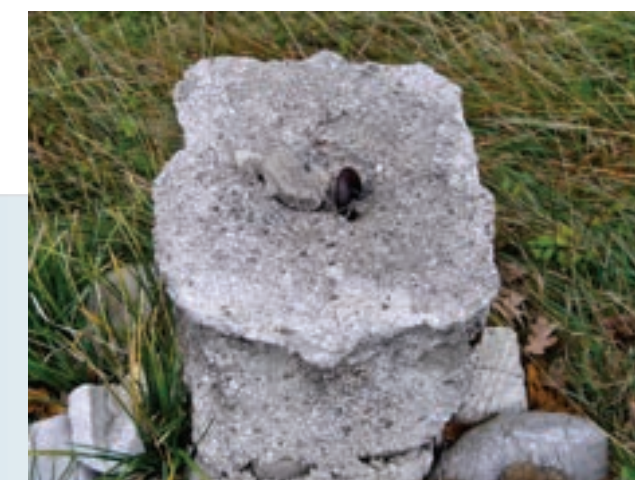
Izseki fotografij, kjer je utrjevalna jeklenica pritrjena že v zabetonirani blok z jeklenim rinkom, poleg pa so še puščeni leseni količki, ki so služili tej funkciji pred tem. (foto: Goriški muzej)
