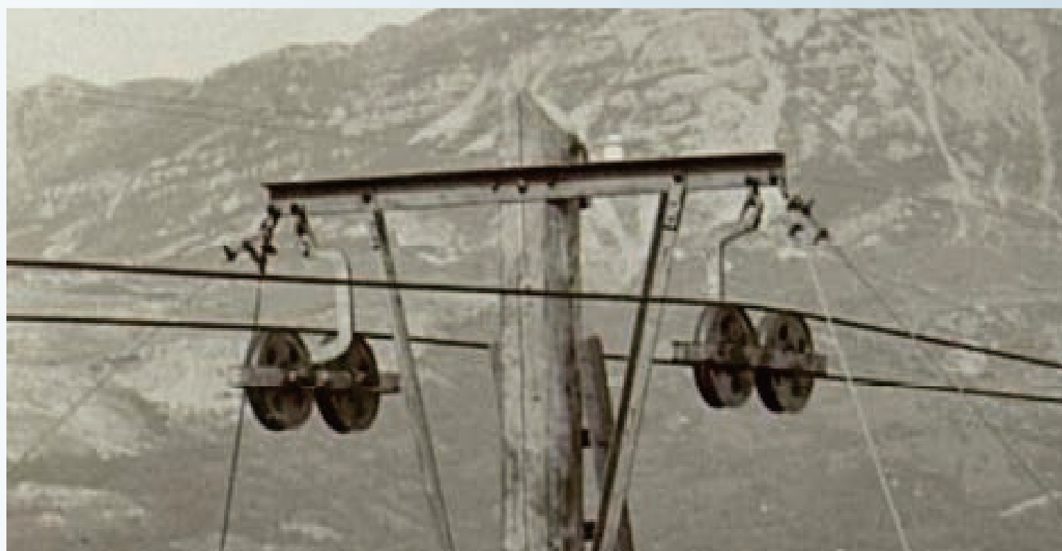
Steber, na katerem je dobro vidna pritrditev jeklenic, ki so učvrstile posamezen steber in bile pripete na sidrišče. (foto: Goriški muzej)
