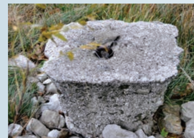
Betonski blok, katerega je lastnik parcele v Lokavcu ob sajenju nasada oljk izkopal in ga ima ob meji parcele kot okras in stol za sedenje. Vsak steber je imel 4 take zabetonirane kovinske zapenjalce. (foto: Boris Blažko)
