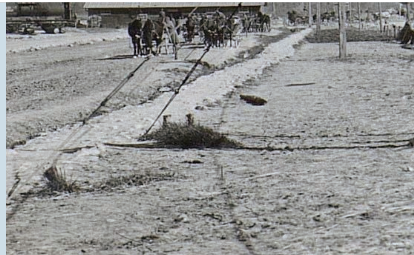
Izseki fotografij, kjer je utrjevalna jeklenica pritrjena že v zabetonirani blok z jeklenim rinkom, poleg pa so še puščeni leseni količki, ki so služili tej funkciji pred tem. (foto: Goriški muzej)
