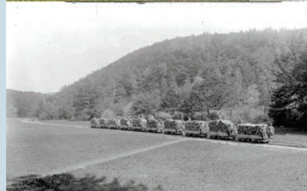
Ozkotirna vojaška poljska železnica na Mali Lazni zaradi nagiba tirov teče na prosti tek. Vsak vagonček je imel svojega zavirača. (fototeka: Goriški muzej)
