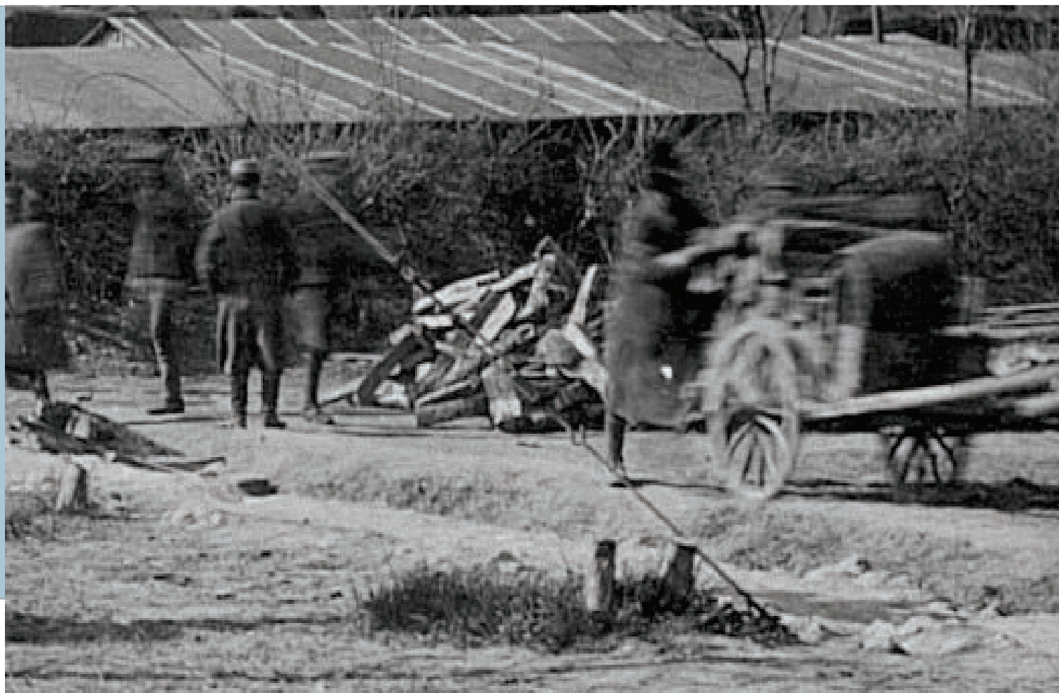
Izseki fotografij, kjer je utrjevalna jeklenica pritrjena že v zabetonirani blok z jeklenim rinkom, poleg pa so še puščeni leseni količki, ki so služili tej funkciji pred tem. (foto: Goriški muzej)
