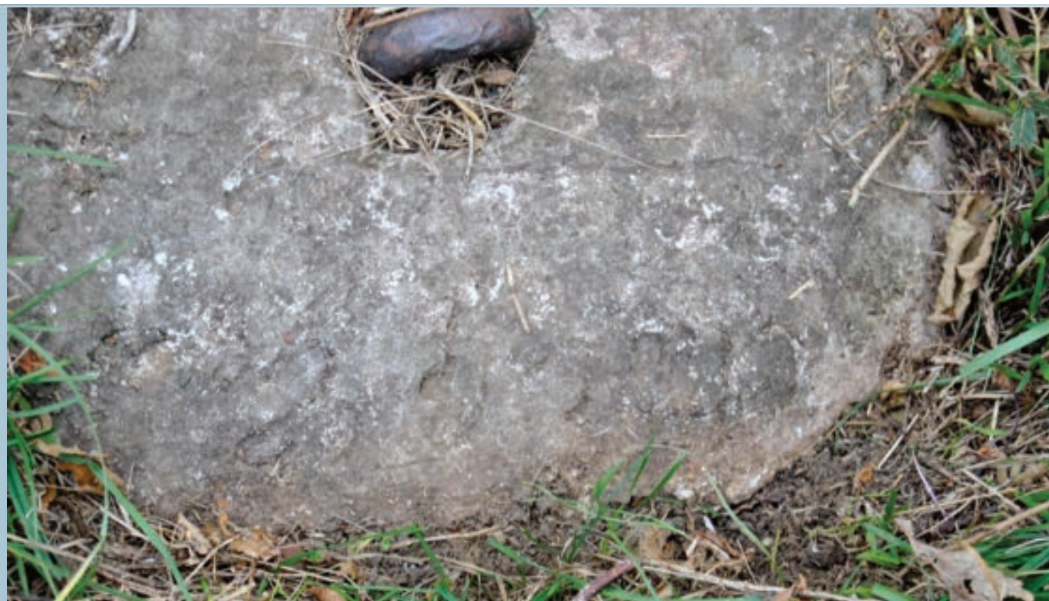
Sidro ima v svojem betonu zapis števil, ki jih je vojak ali ruski ujetnik – zidar pred 105. leti zapisal v svež beton. (foto: Boris Blažko)
