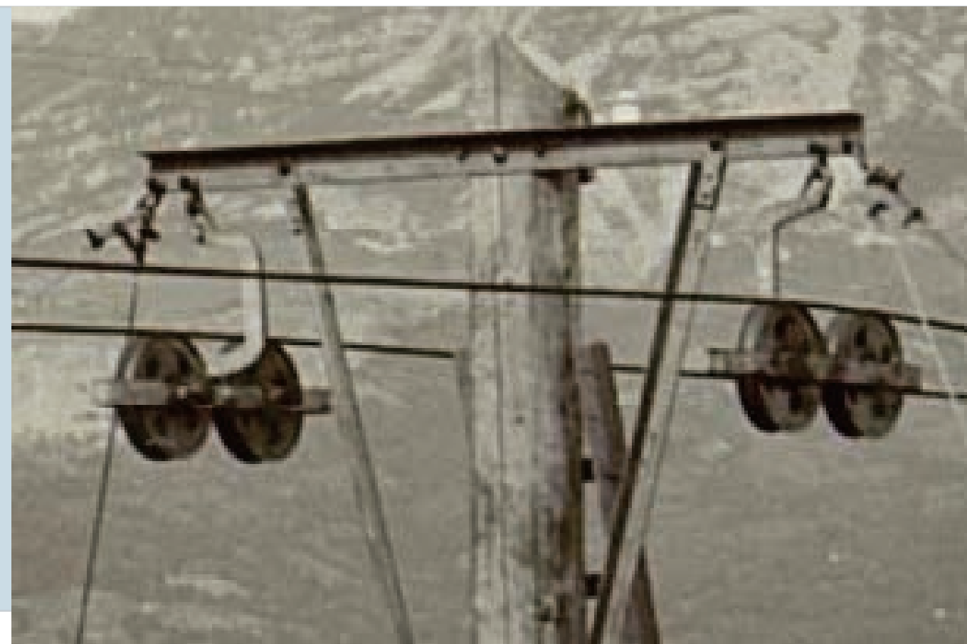
Sistem dveh koles je voziček varneje prešel mimo posameznega stebra. Ko je skupaj z pripenjalnim sistemom prešel čez eno kolesce je drugo kolesce z svojim utorom zadrževala jeklenico v smeri, da ni zdrsnila iz utora na kolescu. (foto: Goriški muzej)
