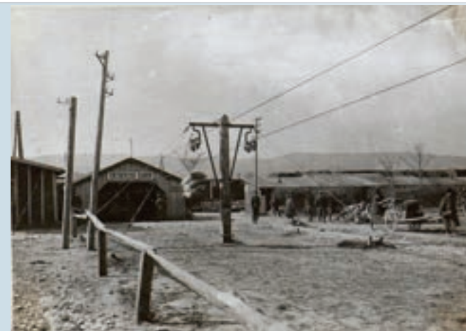
Višina zadnjega stebra pred postajo Nadvojvoda Evgen v Ajdovščini je bila pod 4 metre. Za dosego te višine so morali nižati vsaj 3 stebre pred tem. (foto: Europeana)
