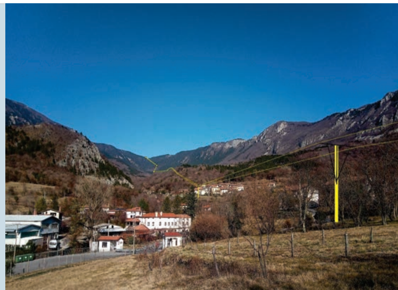
Pogled iz prostora, kjer je stala končna postaja 1. in začetna postaja 2. odseka žičnice, proti Predmeji, kjer se vidi lokacij, oziroma potek ostalih treh odsekov do Predmeje. (foto in grafika: Boris Blažko)
