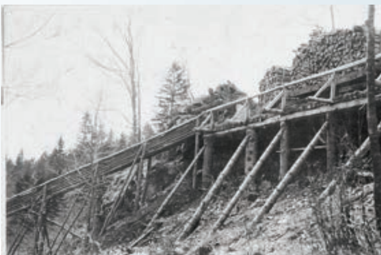
Lesena drča za premostitev višinske razlike med ozkotirno železnico in cesto. V ozadju je viden steber žičnice proti Lokvam. (foto: Europeana)
