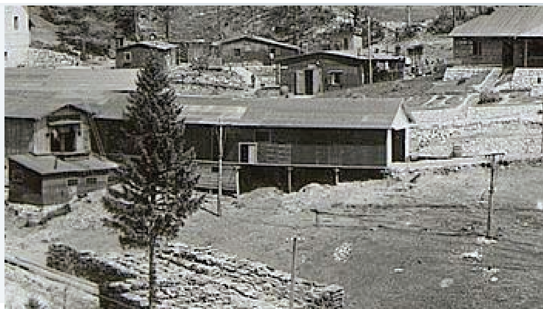
Postaja Nadvojvoda Friderik na Predmeji, kjer se vidi dva zadnja stebra pred postajo, pri čemer je zadnji steber višji, da doseže ravnino odprtine na postajališkem platoju. (foto: Goriški muzej)
