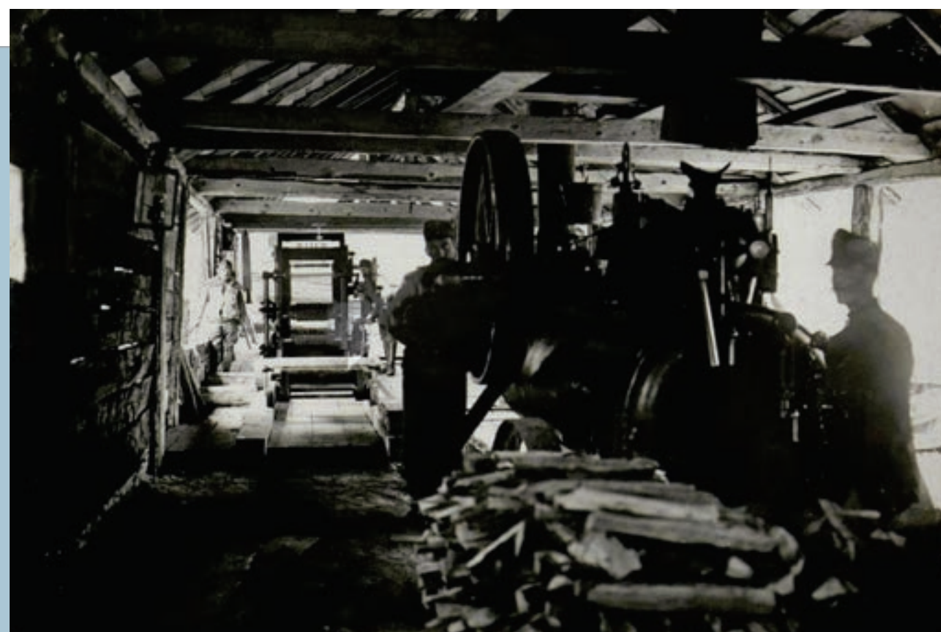
Notranjost žage na parni pogon v Smrečju. V ospredju parni motor s pogonskim kolesom – transmisijo, ki je preko pogonskega pasu poganjala žago in gater z vozičkom, ki je viden v ozadju na levi strani parnega stroja. V ospredju je vidna tudi skladovnica drv za kurjenje parnega stroja. (foto: Europeana)
