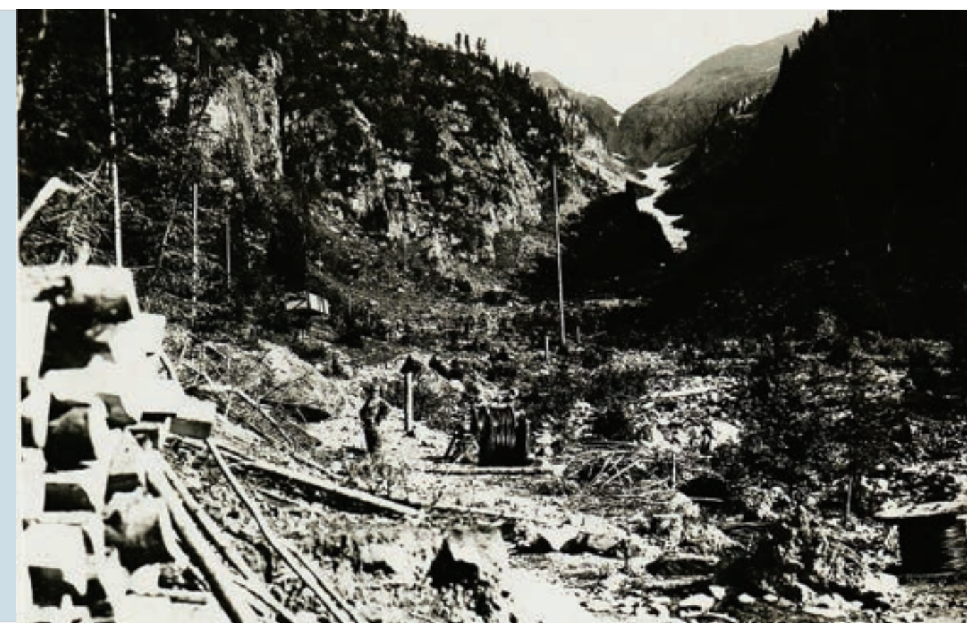
Gradnja žičnice je po samem načrtovanju zahtevala pripravo trase in podiranje odvečnega drevja. (foto: Europeana)
