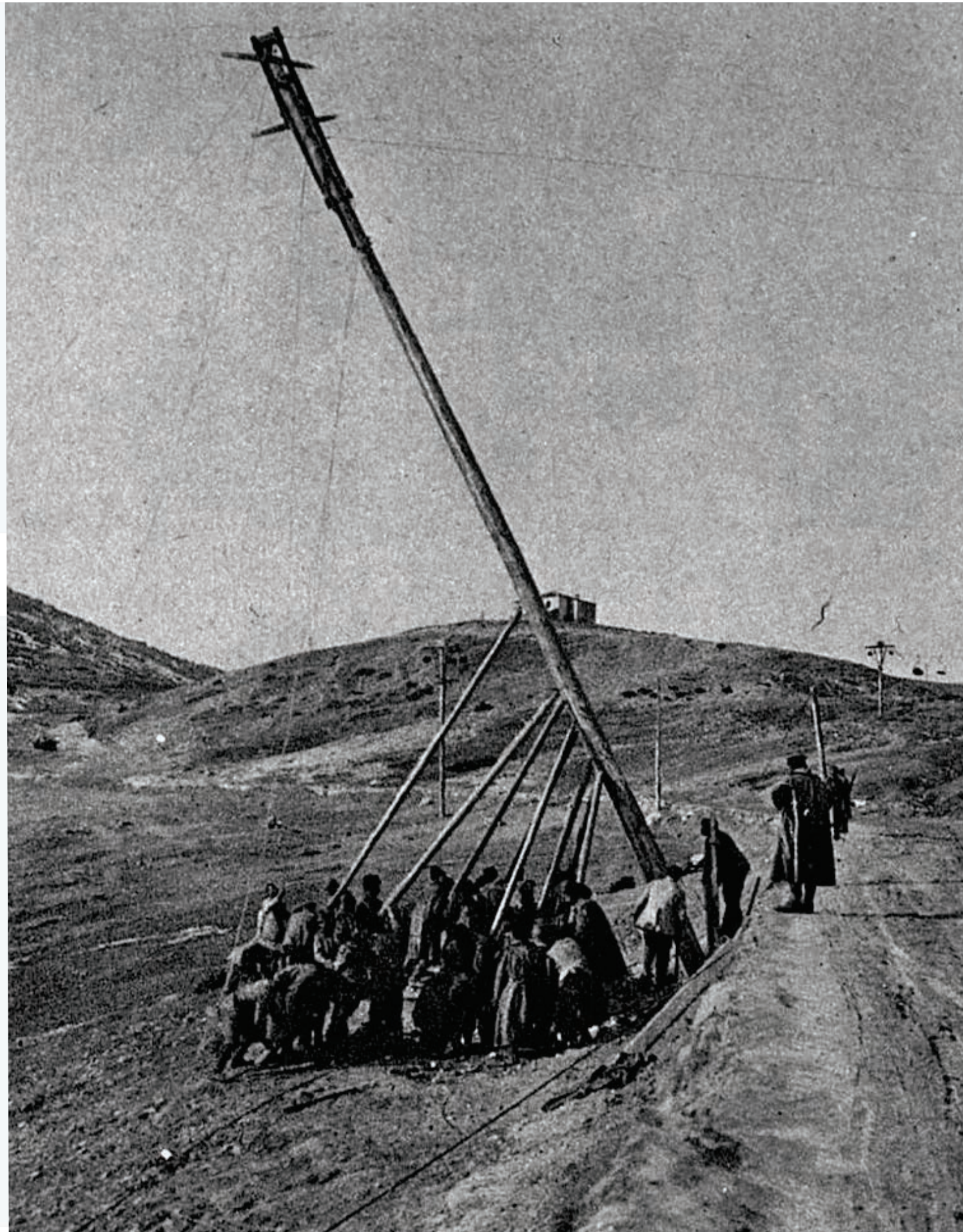
Postavljanje stebrov je potekalo ročno na »gasilski način«. (foto: Bleichert Feldseilbahnen - BLEICHERT & Co.)
