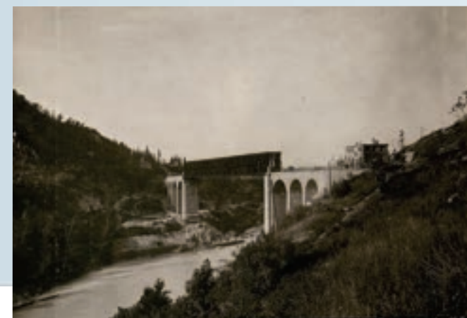
21. maja 1918 je avstro-ogrsko vojaštvo za silo usposobilo most, ko so mu dodali železno konstrukcijo. (foto: Goriški muzej)
