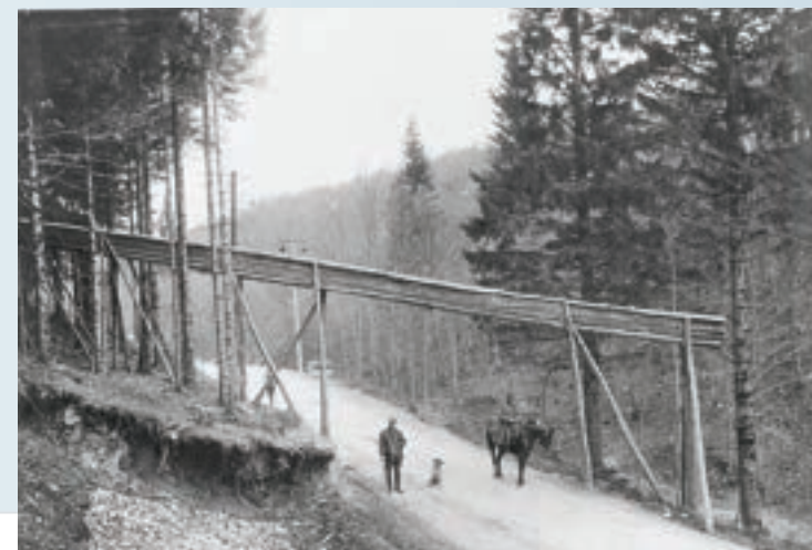
Lesena drča za premostitev višinske razlike med ozkotirno železnico in cesto. V ozadju je viden steber žičnice proti Lokvam. (foto: Europeana)
